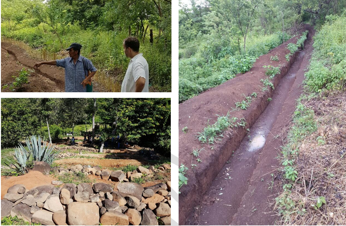
Figura 8: Obras de conservación de suelos: acequias, barreras vivas y muertas (fase 1 del proyecto)
